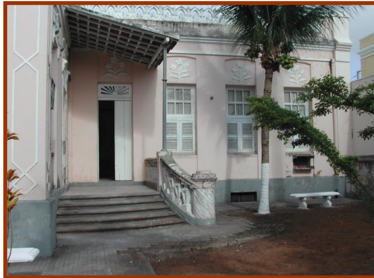
Figura 38. Fachada Principal do G.E. Augusto Severo – Acesso de alunos, registro fotográfico 2005.
