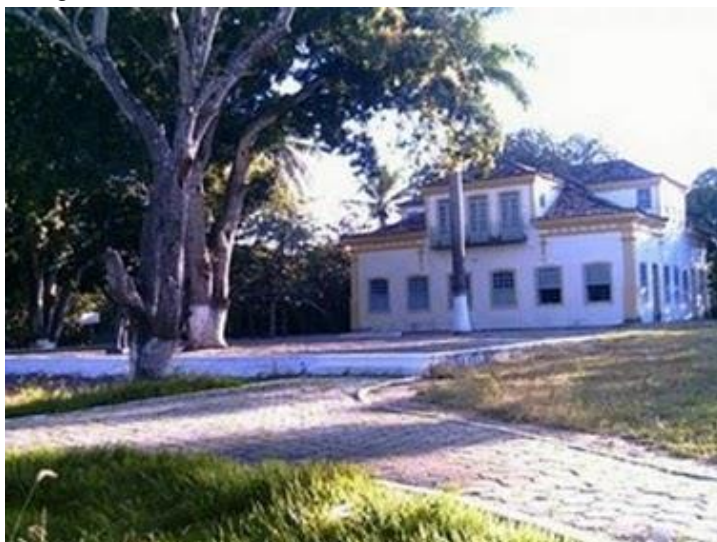
Figura 12 – Vista do Solar do Ferreiro Torto - Macaíba/RN
