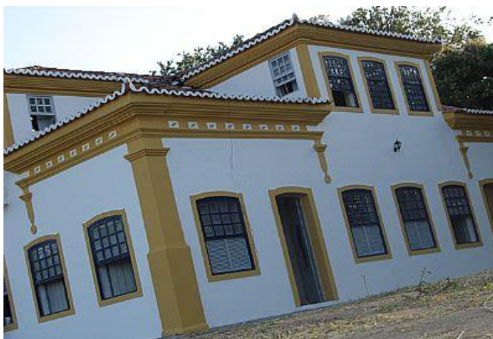
Figura 13 – Vista do Solar do Ferreiro Torto - Macaíba/RN
