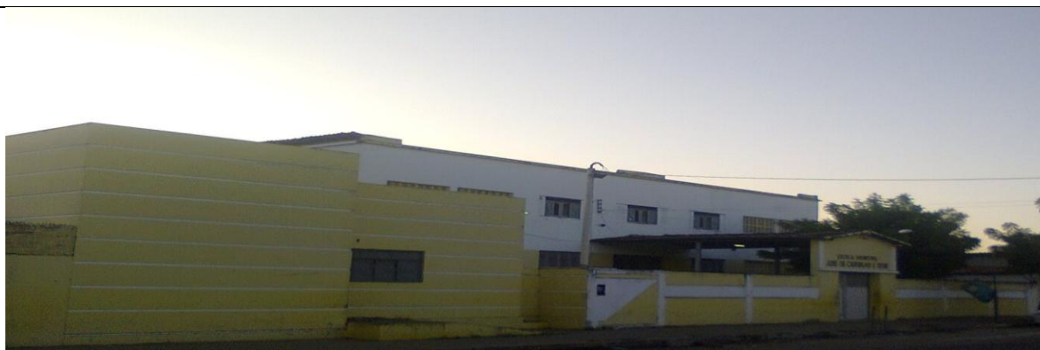
Figura 02- Fachada principal da Escola Municipal José de Carvalho e Silva
